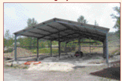
Travaux effectués sur le dépôt de matériel de la société, ses bureaux et le logement du gardien
